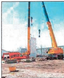
Für das Nahversorgungszentrum werden derzeit Fertigteile angeliefert. Foto: Hentschel
